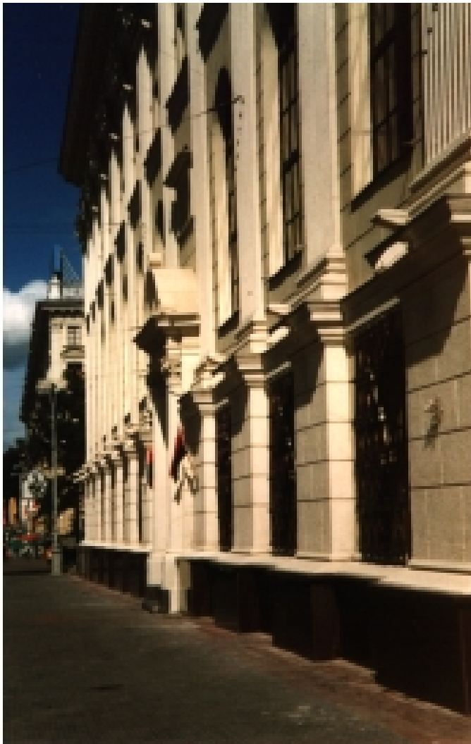
Рис. 3. Дневной вид смонтированной осветительной установки
